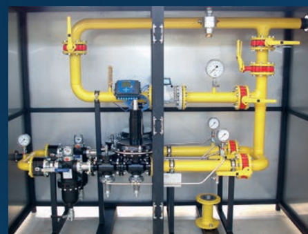
Distribuce plynu: redukční stanice (EN 12186 a místní předpisy) Gas distribution: Pressure reducing station (acc. EN 12186 and local regulations)
